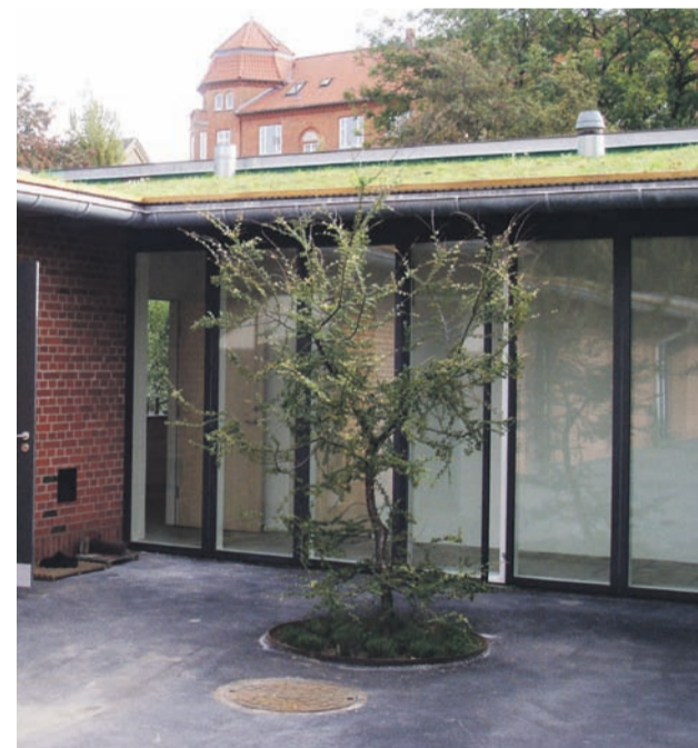
Mos sedumtaget på kirkegårdsbygningen, med helt op til 80% optagelse af nedbør.
