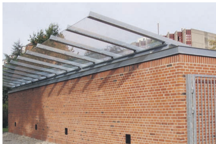
Den nye bygning er udelukkende opvarmet af jordvarme. Taget er ligeledes forberedt til solenergi. Anlægget vil blive færdig installeret når kirken har penge til det.
