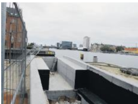
Fundament til Cirkelbroen
