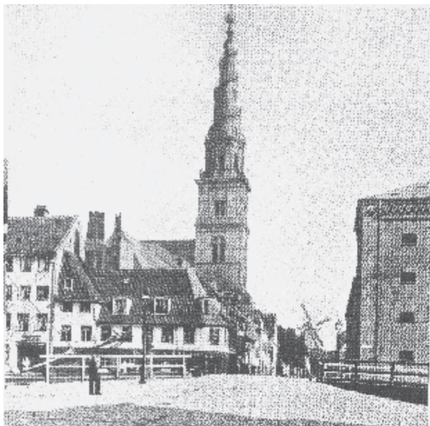
Vor Frelser Kirke i Sankt Annæ Gade med Snurrebroen i forgrunden. Bygningen til højre er bagsiden af tugthuset. Foto 1872 Billedet er fra den omtalte bog.
