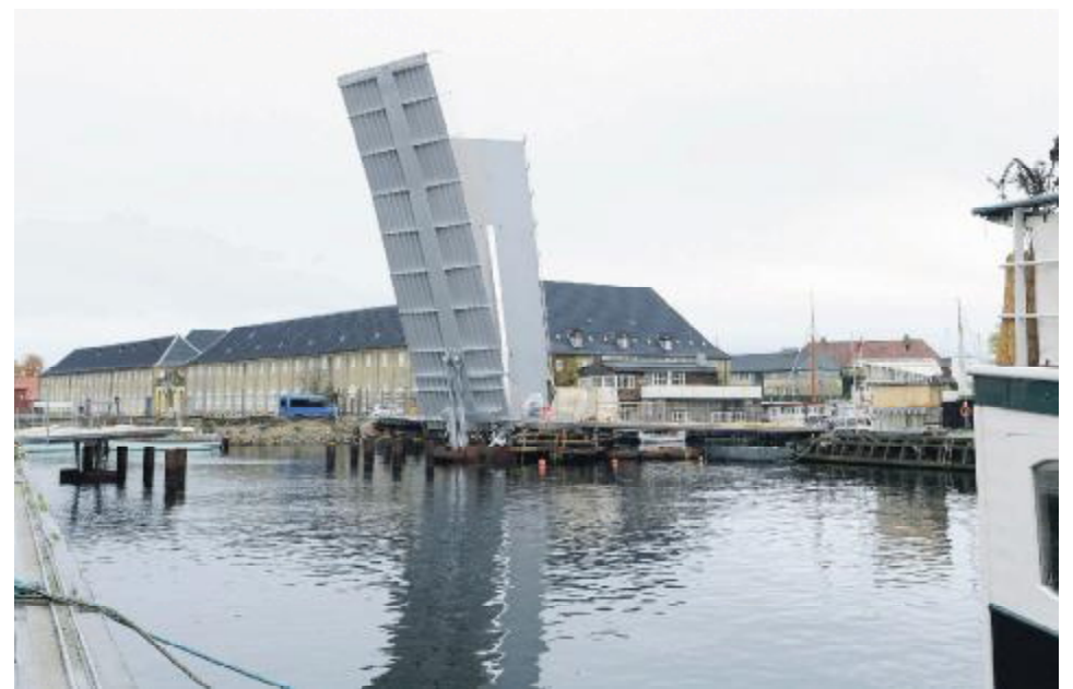
Broen over Trangraven er blevet et uskønt monster af beton. (Foto af Henrik Ploug, FAF og DBA).
