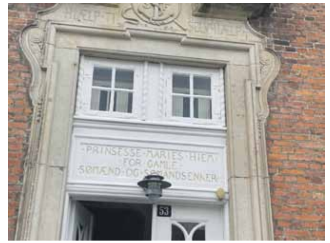
Indgangen i den 'nye' afdeling af sømandshjemet ud mod Overgaden neden Vandet.
