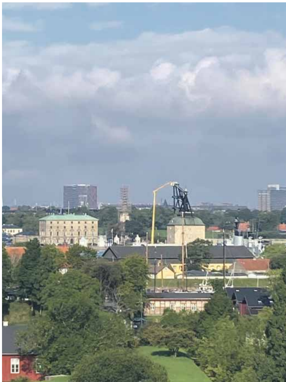
Mastekranen vedligeholdes. Man kunne sige "kran over kran".
