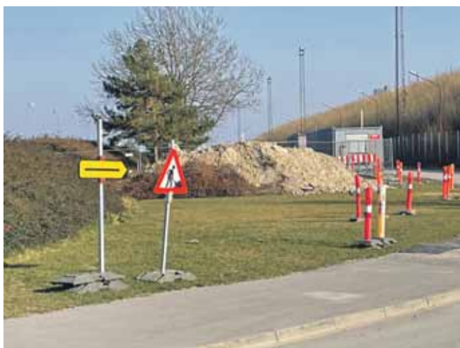
Omkørsel ned til byggepladsen
