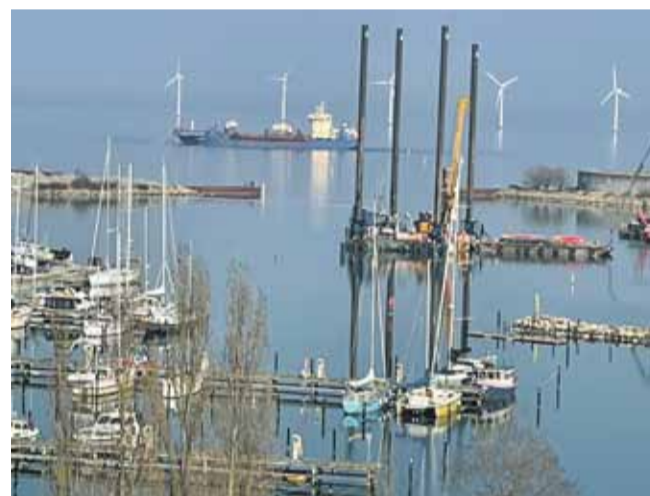
Der arbejdes på etablering af vej umiddelbart uden for Margretheholms Havn
