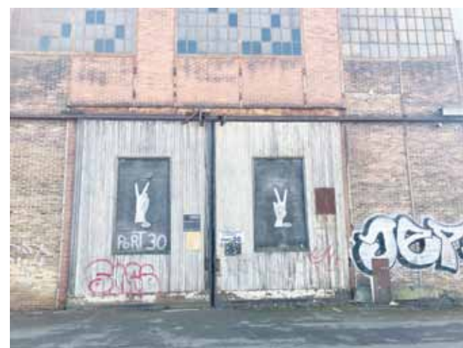
Reffens gamle fabriksbygninger huser mange sjove ting. Her er det det 5000 m2 store engros lager for teak- og andre møbler m.m. P.t. lukket, men facaden kan man da altid nyde, med al sin rustikke charme. Foto ebb
