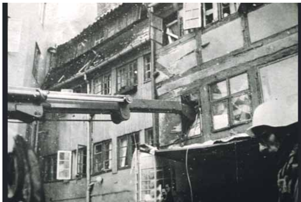
En rambuk gennem husvæggen til en god bolig. - Fotograf: Ukendt
